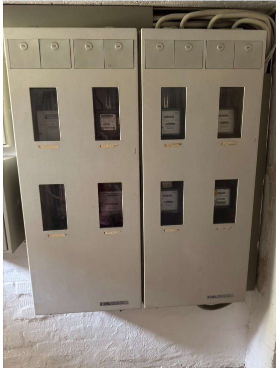
Stromzähler - zentralisiert
